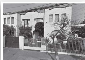
Población de Correos y Telégrafos Carlos Lira Carrera. Google Street View
