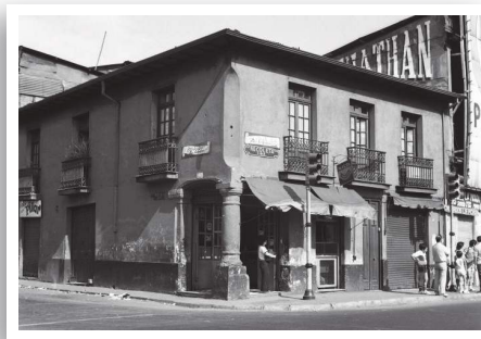
Casa del Pilar esquina Recoleta, 1985. Archivo Fotográfico Departamento de Arquitectura MOP
